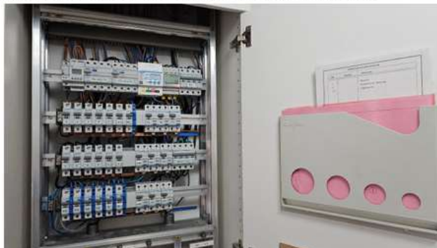
13.1.1.1 Recherche de défauts après retrait de la protection (installation ouverte)
